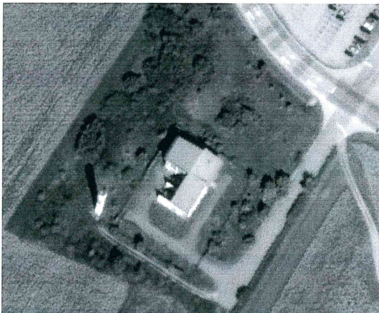
Слика 1 – Трафо станица 35/10 kV Аеродром
